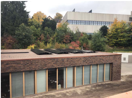
PV-Anlage auf Bürotrakt
